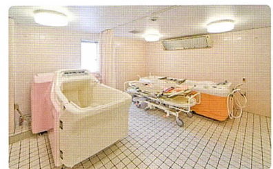
安全・快適に入浴が楽しめる最新の浴槽を完備した特浴室
